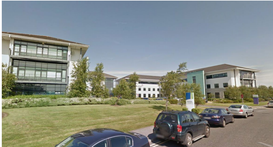
Adjoining office park (Aviva / RSA)
